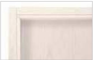
VISTA ESTERNA EXTERNAL VIEW
